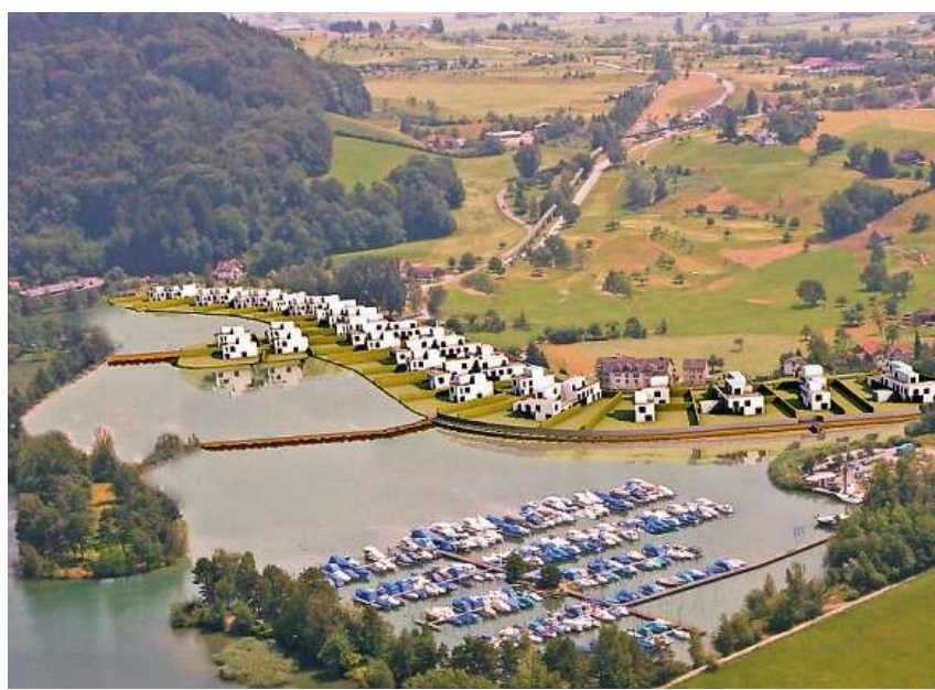
Nuoler Buchten: Ist nach dem Baustopp vor dem Baustopp?
